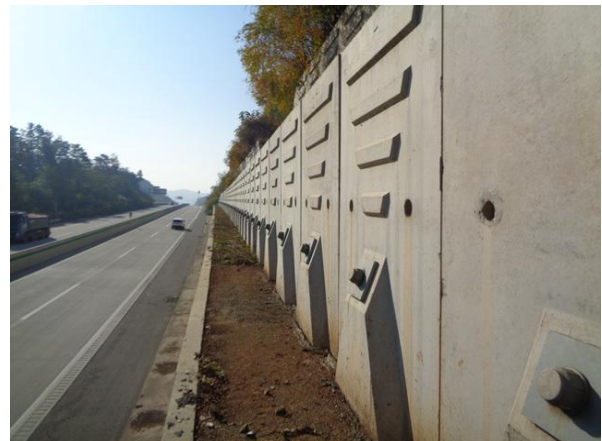
지반 기초부 상태양호
