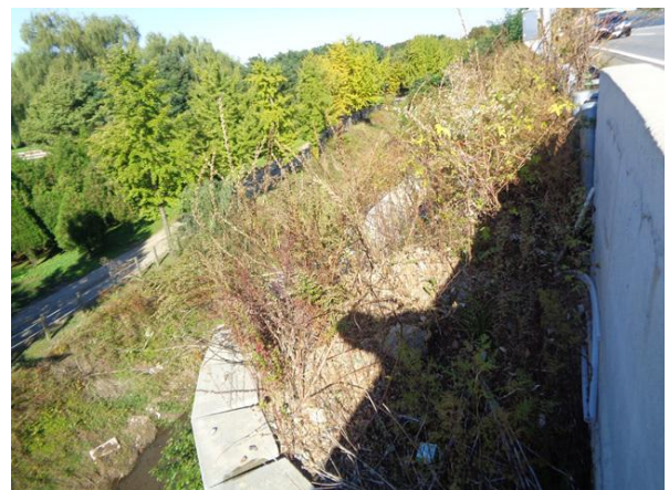
상부 성토부 전경
