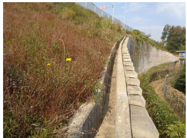
상부 성토부 전경
